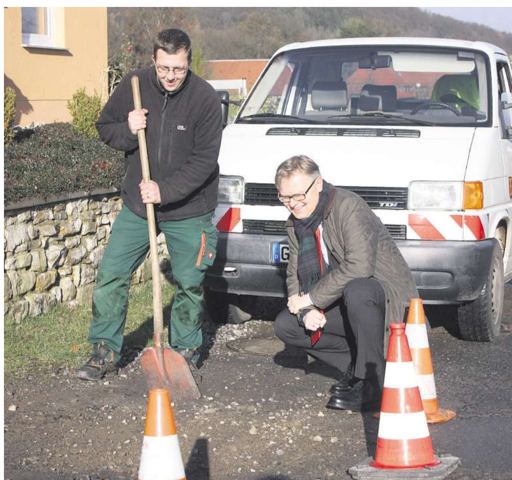
Jan-Philipp Bruchmann (li.) und Bürgermeister Johann-Karl Vietor begutachten den gefüllten Erdfall. RF
